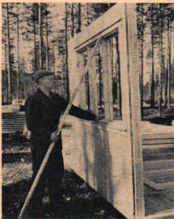
Två man har avdelats för bygget, och efter en timme reses första blocket . . .
