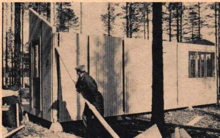
För att få hörnblocken att passa ihop exakt — och det är mycket viktigt — måste man sträva upp väggarna, exempelvis på detta sätt, med en bräda.
