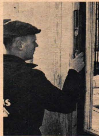
. . . men sedan måste man kontrollera att vinklarna är de riktiga.
