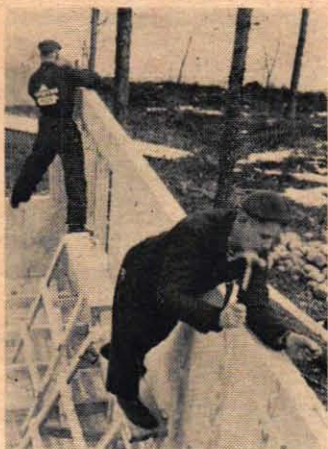
Ovanpå väggblocken spikas "hammarband", som takstolarna fästes på.
