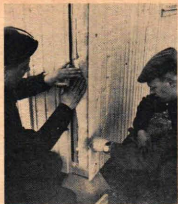
... och att ordna mineralullsisolering i knutarna innan knutbräderna spikas fast.
