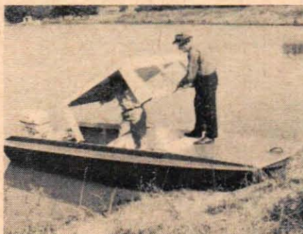
Duracraft är en amerikansk aluminiumbåt och en intressant detalj är det snabbt demonterbara kabin-taket. Detta är utfört i aluminium och kan snabbt monteras på om vädret blir dåligt. Kabin-taket kan f.ö. också behändigt svängas åt sidan.
