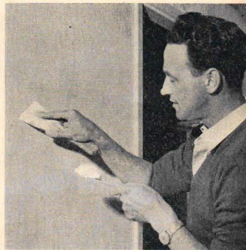
Det kan vara lämpligt att använda två spackel-spadar. En för spackelfärgen och en att arbeta med. Fint underarbete ger gott slutresultat.
