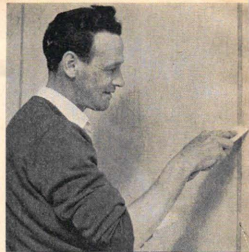
Utspackling av ojämnheter. Man lägger spackelfärgen över de skadade ställena i en riktning och för bort överflödigt spackel genom att dra spaden vinkelrätt mot den första riktningen.
