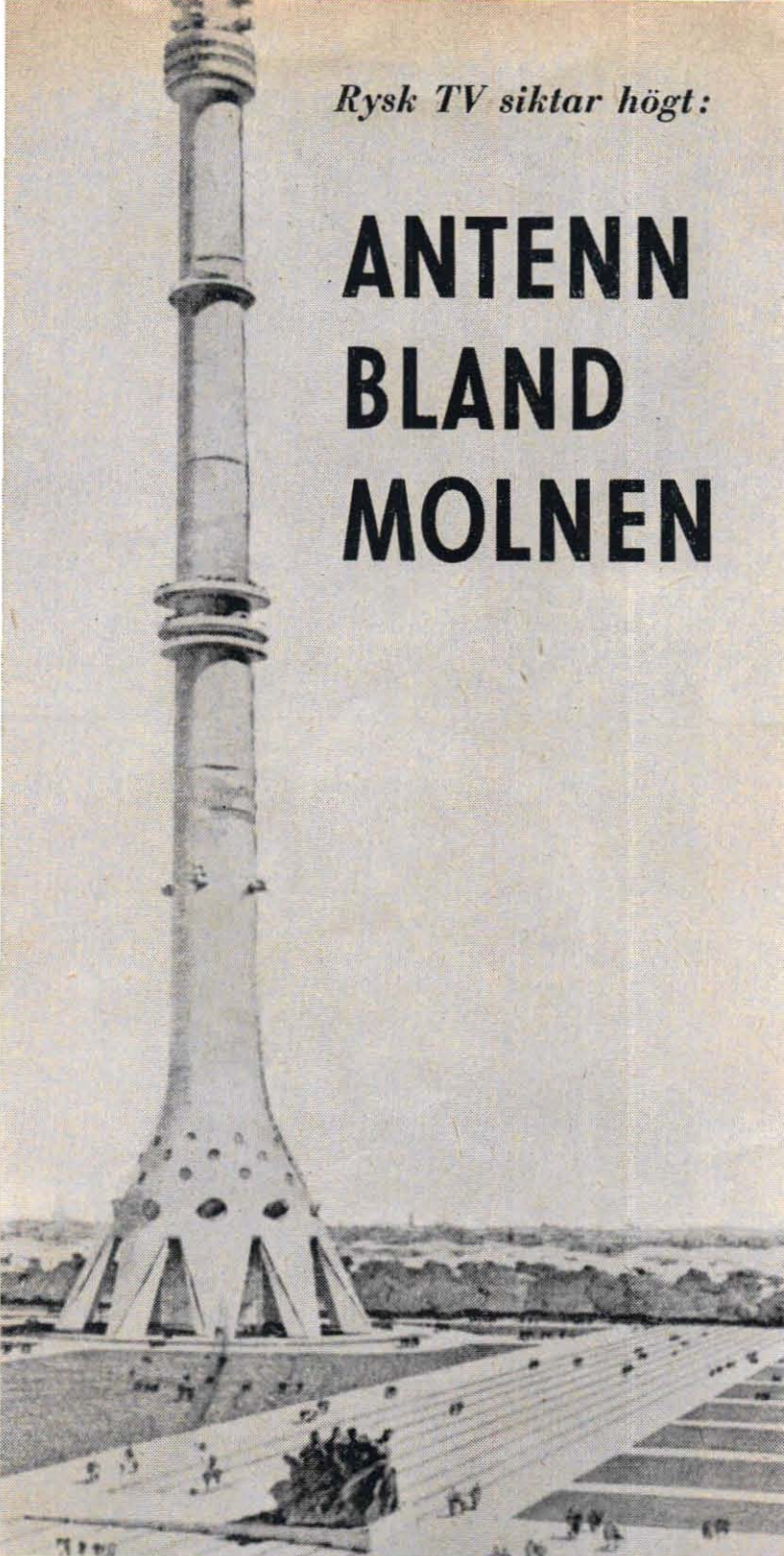
Arbetet med gjutningen av det väldiga betongfundamentet för världens högsta byggnadsverk, Moskvas TV-torn, har börjat. Grunden blir 62 m bred.
