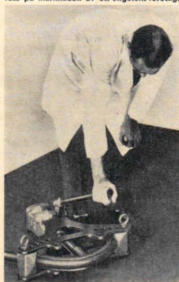
En hydraulisk rörböckningsmaskin för rördimensioner upp till 1,5" har Introducerats på marknaden av ett engelskt företag.
