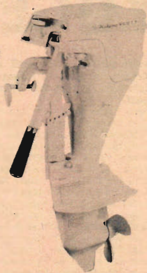
Fishing Scott har kompakt, ovanlig kåpa. Motorn ger 7,5 hk vid 4 500 v/min. Volymen är 164 cc och vikten är 20 kg.
