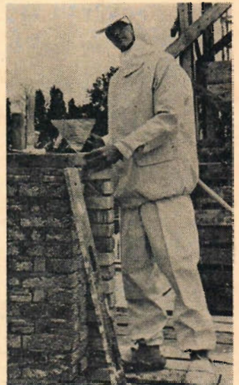
En dansk murare testar här den nya arbetsdräkten som skapats av Danska Byggnadsforskningslaboratoriet och skall möjliggöra utomhusarbete året om. 500 byggnadsarbetare landet runt håller nu på att testa arbetsdräkten.
