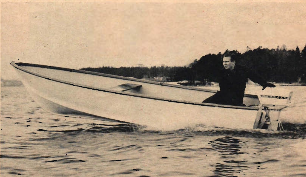
Plastbåten Cavalier tillverkas av Marieholms bruk. Den är 4,35 m lång och 1,84 m bred och vikten är omkring 135 kg. Relling, durkar och tofter är tillverkade av mahogny och akter- och förtoften tjänstgör som inbyggda flyttankar. Cavalier kan utrustas med utombordsmotorer på mellan 3 och 10 hk. I standardutrustningen ingår förkromade metallbeslag samt åror och som extra utrustning finns kapell. Cavalier säljs bl. a. av AB Gösta Berg och priset på båten är 2 080 kr.
