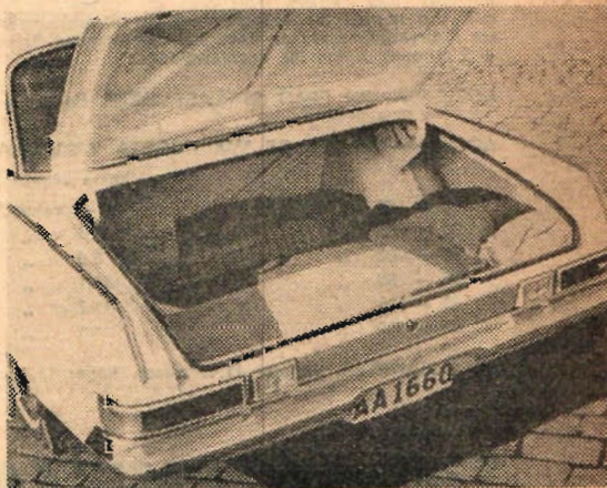
Bagageutrymme! är mycket rymligt men störs av röret från påfyllningen i vänster flygel till tanken.
