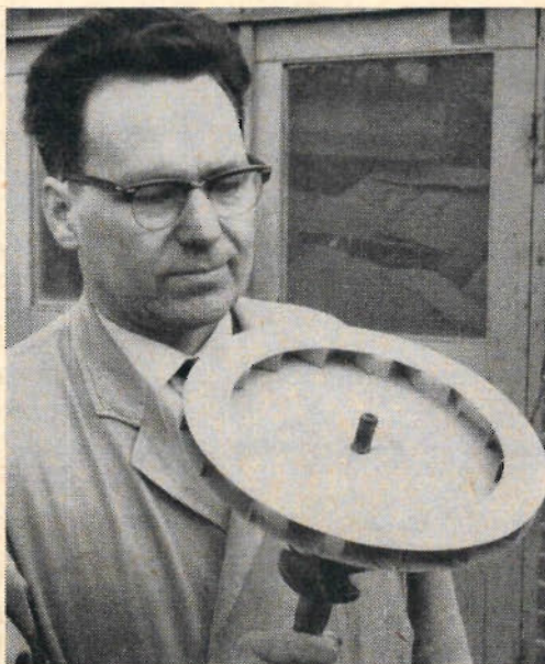
Fabrikschef Karl Dahlman med fläkten till gräsklipparen. Detta är fläkten i sin slutgiltiga utformning. Prototypens fläkt var av betydligt mer komplicerad tillverkning.
