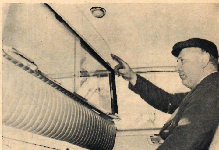
Sven Emanuelsson pekar på de perforerade stålplåtarna mellan glasrutan och taket.
