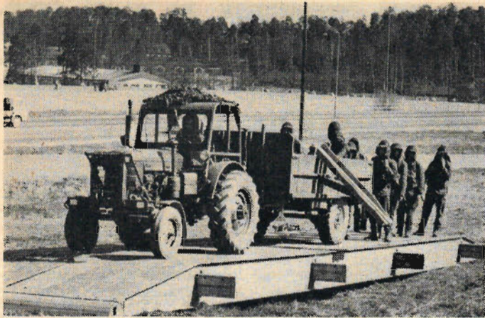
När 22 minuter hade gått var bron helt färdig och första fordonet passerade.
