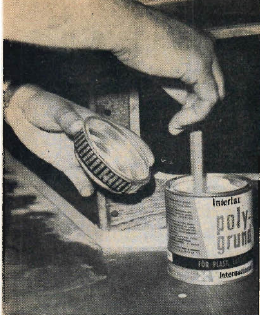
I det här fallet är det fråga om tillblandning av primern Interlux Polygrund. Sedan härdaren hållits i huvudburken rörs primern noggrant om.
