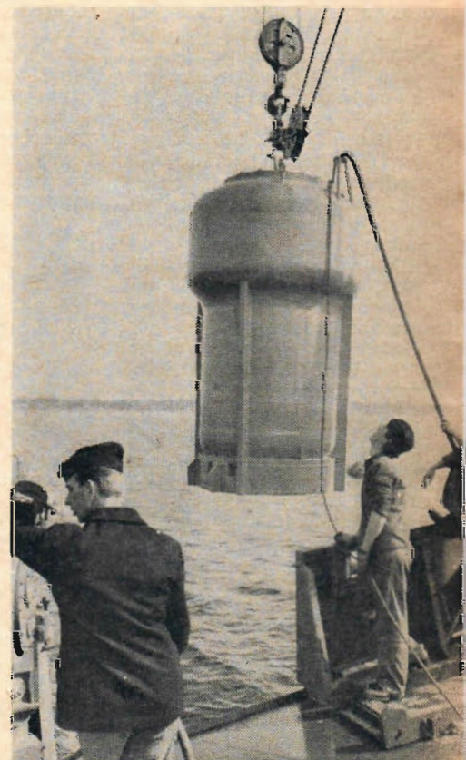
Dyarklockan har kraftiga, långsgående styrskenor, som styr klockan in i rätt läge när den skall låsas fast vid rekompansionskammaren.
