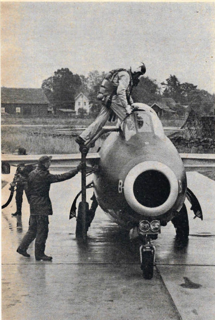
Piloten klättrar in i sittbrunnen för ett beredskapspass. Han skall sedan sitta i planet medan motorn är i gång — det bränsle som går åt ersätts genom att nytt matas in i planet under tiden — och vid larm tar det bara några få sekunder att köra ut på betongbanan och dra på för start.
