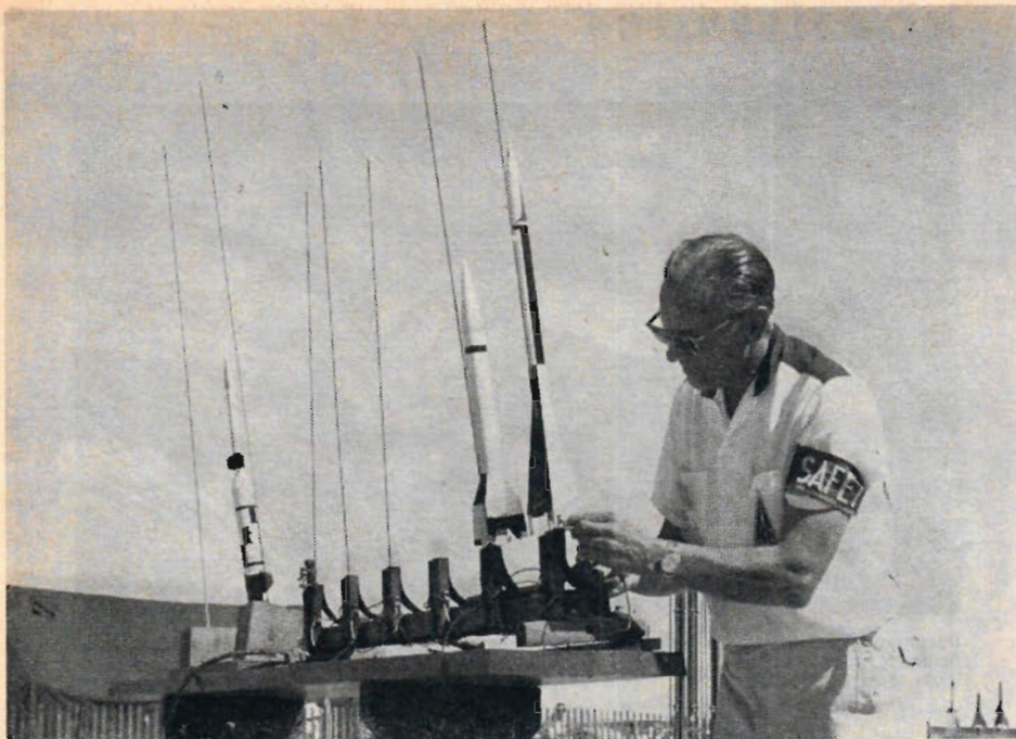
Säkerhetsfunktionären kontrollerar raketerna före avfyringen. Lägg märke till den pianotråd, som styr raketerna vid starten. Bilden har tagits vid det fjärde amerikanska mästerskapet i modellraketflygning.
