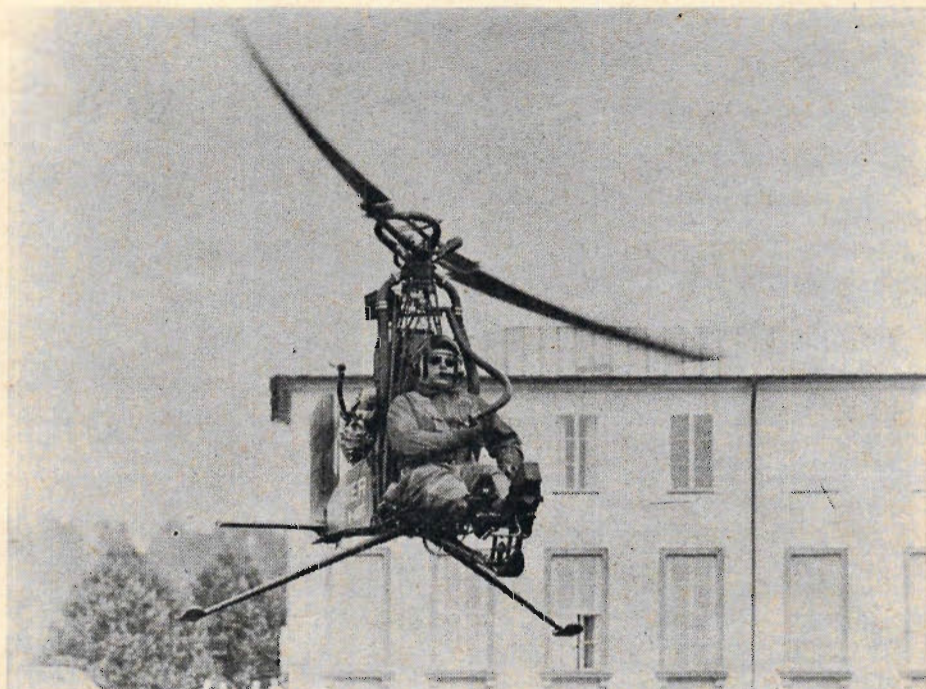
5 Tre sekunder senare är ekipaget redan på 25 meters höjd. Genom att dra upp rotorn i övervarv och sedan ställa om bladvinkeln för stigning kan Do 32 företa hopp upp till 25 meters höjd på tre sekunder. Maxfarten är 120 km/tim.
