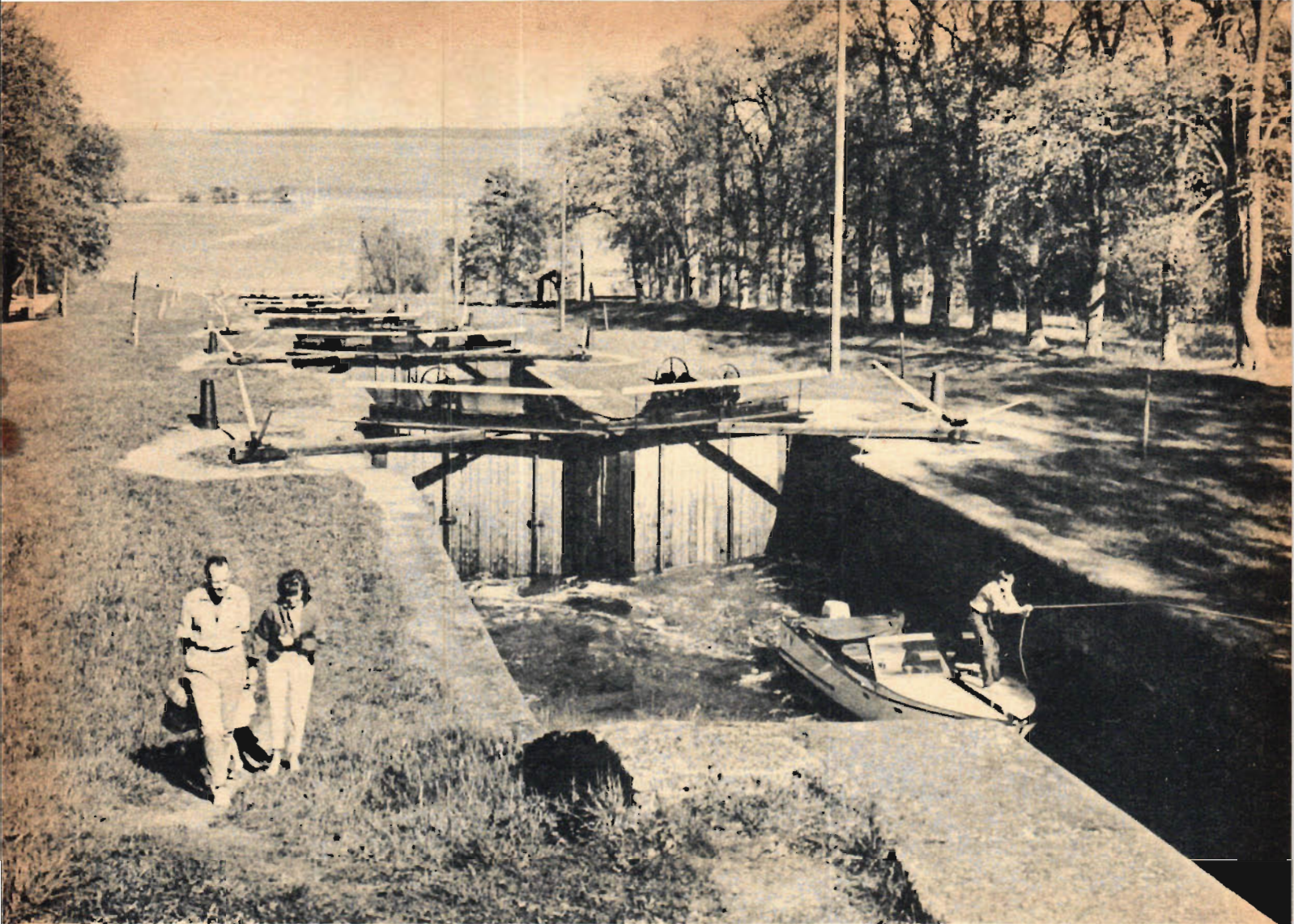
Bergs slussar är en imponerande anläggning. Elva slussar i följd sörjer här för att båten lyfts 40 m över sjön Roxens yta. Sju av slussarna är kopplade i en enda trappa och under slussningen får besättningen gott om tid att beundra den berömda utsikten över Roxen. Vreta klosterkyrka ligger nära slussarna och en utflykt dit blir en välkommen vilopaus efter slussningsarbetet.
