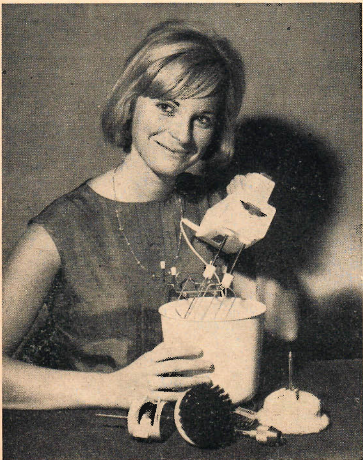
En liten praktisk hushållsmaskin visades på "Gör-det-själv-mässan" i London. Det är en mixer vilken man kan använda även som bormaskin, slipmaskin eller att polera med, då det till maskinen finns olika tillbehör.
