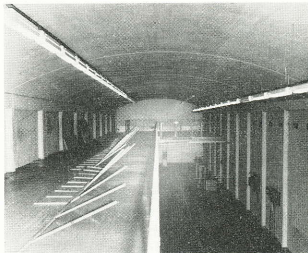
Läktaren i tunnel VI under rivning
