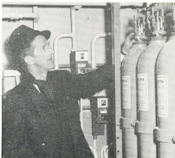
Ett försvarligt batteri med kolsyretuber står i beredskap i ett särskilt rum i motorprovbocken. Det finns tre batterier med 24 tuber i varje. Varje batteri kan utlösas var för sig automatiskt eller manuellt. Den manuella utlösningen kan ske från provrummen. Här kontrollerar brandförman Harry Odenhult kolsyretubernas vikt.
