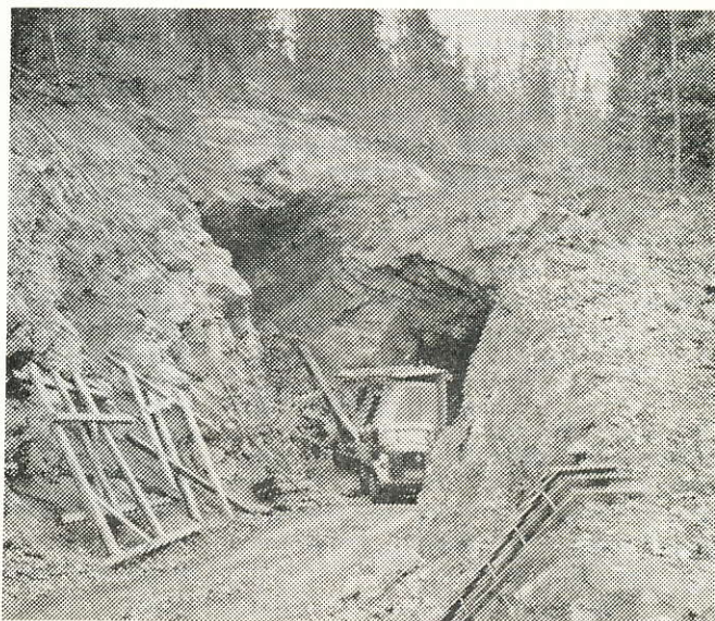
Bild 4. Inslaget för motorprovanläggning (okt. 1951).
