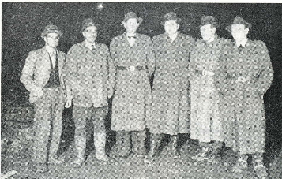
Dom höll i skaftet. Fr. v. kamrer Karl Hemström, öververkmästaren för sprängning Gustav Eriksson, biträdande platschef Alfons Svedborg, platschef Lennart Hägglund, öververkmästare för inredning och betongarbeten Anders V. Bengtsson och ritnings- och kostnadskontroll ingenjör Sigvard Samuelsson.
