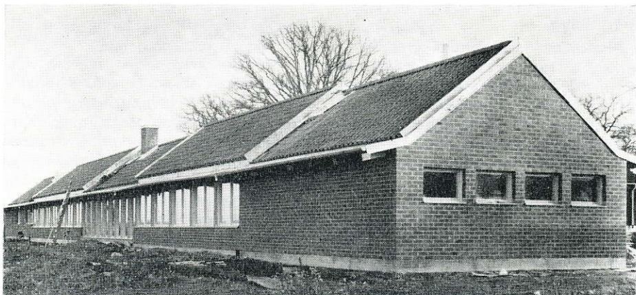
Elevhemmets nya tillbyggnad
