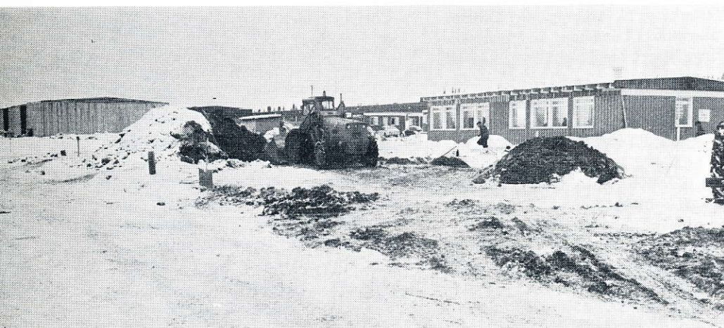
▲ Exteriör i dag. Till vänster, förrådsbyggnaden och till höger kontoret (barnstugan). Där schaktmaskinen arbetar kommer omkläds-, tvätt- och matrum att byggas under vecka 49.
