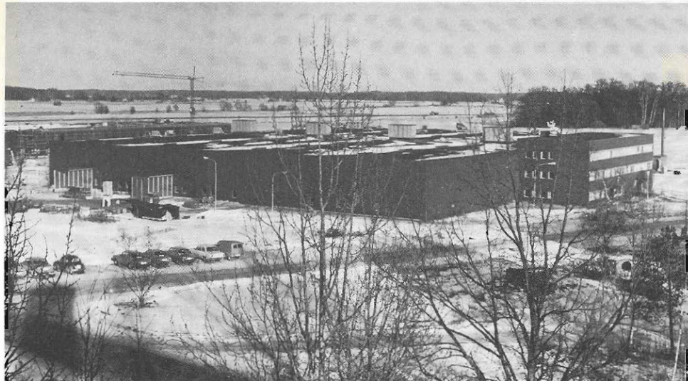
En del av Arbogaverkstaden. Här den nya motorreparationsverkstaden.
