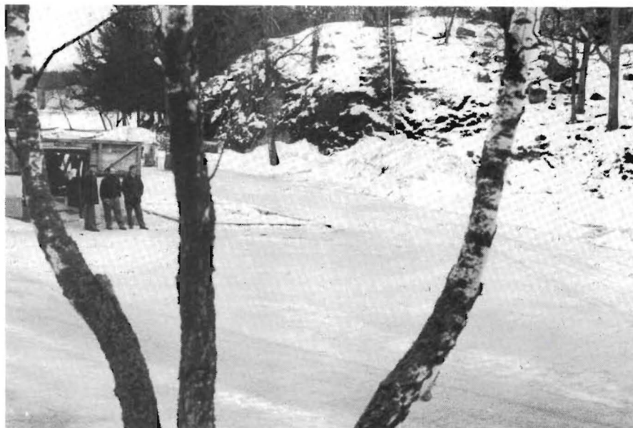
Här står Åke Entoft, Conny Sirby och Anders Eriksson framför resterna av den gamla VVS-verkstan. På den platsen kommer driftverkstan att växa upp och dess östra fasad att se ut som på stora teckningen. Till november alltså.
