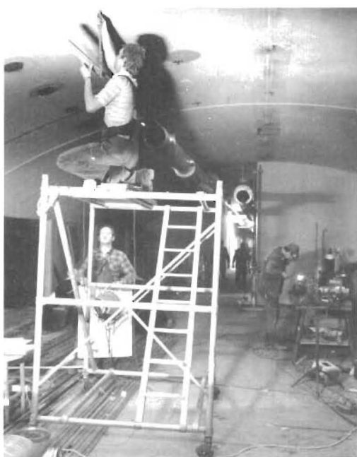
En man att se upp till i tunnel 5 är Mikael Karlsson, där han uppflugnen på arbetsställningen tycks mäta höjd över havet. Den som ser upp till honom är Alf Ståhl.
