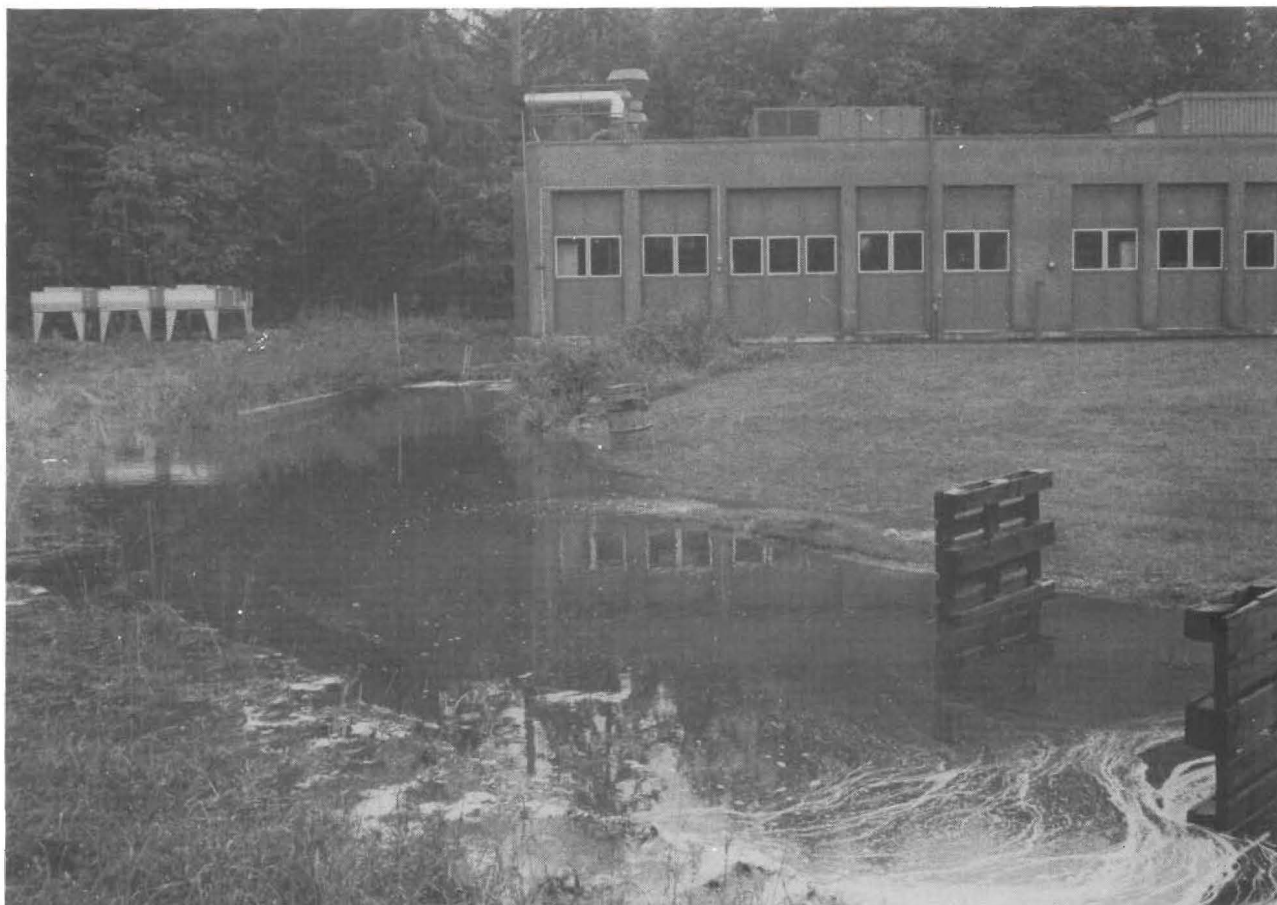
Apparatprovhuset förvandlades för ett dygn till en viadukt. Vattnet forsade in på ena långsidan och ut på den andra. Nedfarten till källaren liknade mest en segelled.
