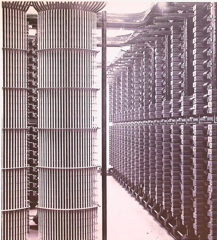
Multiplar från baksidan t.v. och stativ med sericömkastare t.h. Foto från år 1924. LME Fotoarv.
