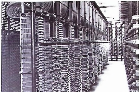
Stativ VIII t.v. med sökare och ledningväljare, fotografi från år 1924. LME Fotoarv.
