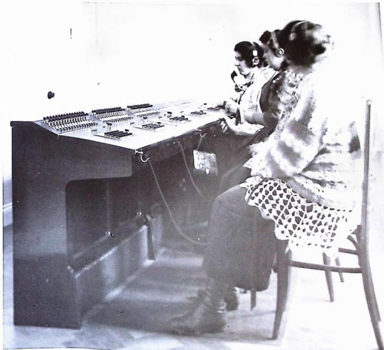
Knappsatsbord på Norra Vasa för uppkoppling av samtal från manuella stationer. LME Foto: d.
