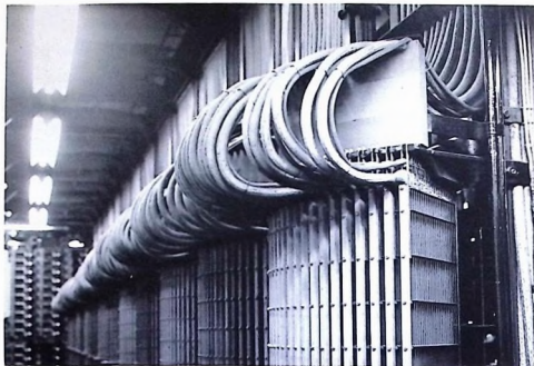
Kablarnas anslutning till multiplarna. Tot Fotokont. 1985.
