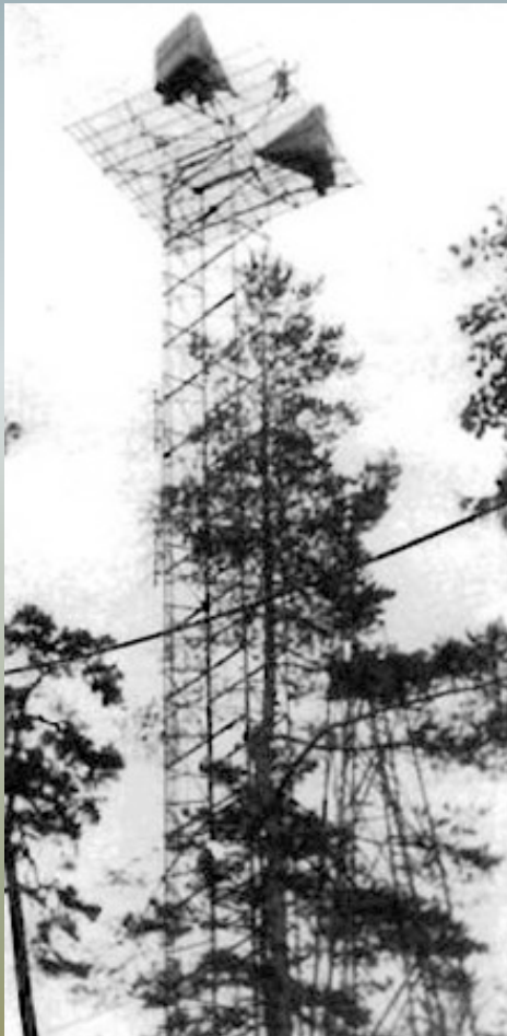
Antenntorn med två Siemens linsantennor
