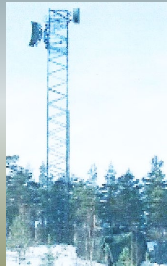
TS9000 nätanslutningspunkt (NAP) grupperad vid FTN-anläggning.
