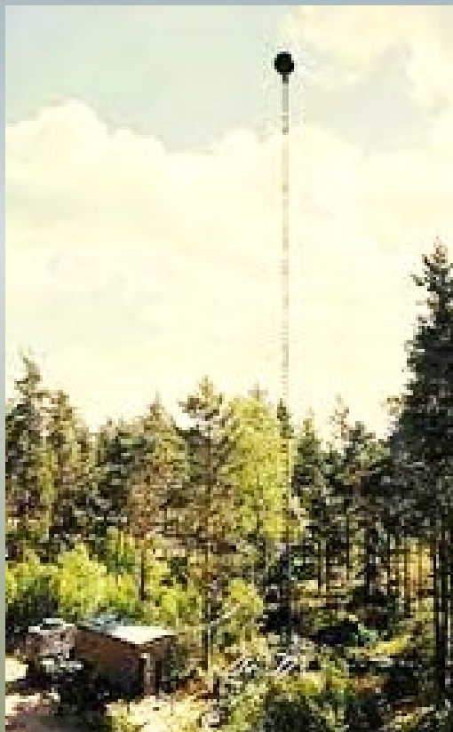
RL-47 med antenn i "kulradom"
