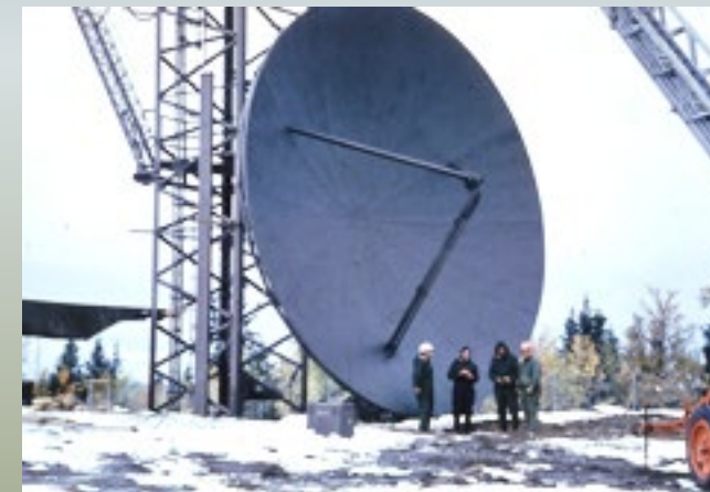
RL-71 antenn. Ingick i scatterstråket Östersund till övre Norrland. I drift 1962 - 1972
