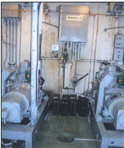
Elkrafttrum med motorelverk
