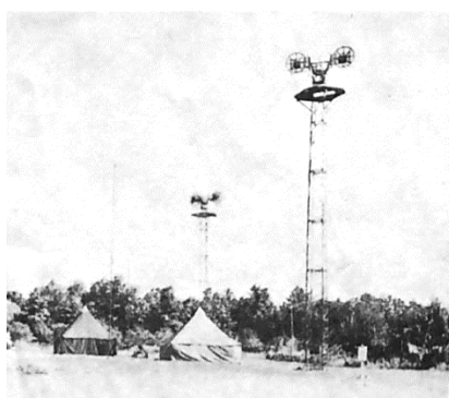
BILD 5 TVÅ ÄNDSTATIONER BILDA EN RELÄSTATION
