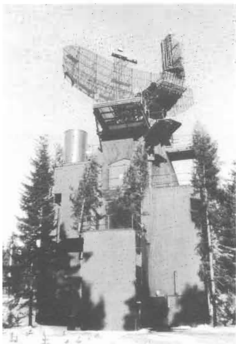
Ovan den franska storstationen PS-66 och på föregående sida den höga lågspaningsstationen PS-15 med lång räckvidd för de lägsta höjderna.
