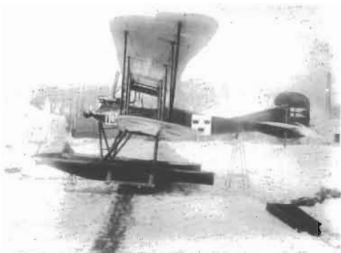
Ett par av Marinens flygplanindivider från tiden mellan 1915–1920. De är båda tagna på samma plats vid flygverkstaden vid Stockholms örlogsvarv – Galärvarvet på Djurgården (Nordiska museet i bakgrunden). Överst en THULIN typ G med en 150 hk Benz-motor (toppfarten angavs till 135 km/h). Maskinen byggdes i fem exemplar och skänktes av Allmänna försvarsföreningen. I tjänst från 1916 till 1921.
