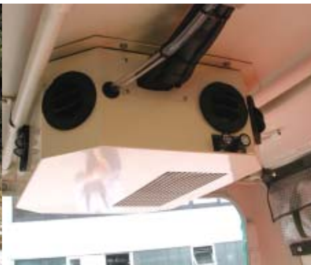
Köld- och värmeanläggningen ser till att man kan hålla 20 grader i vagnen oavsett om det är +40 eller -40 grader utomhus.
