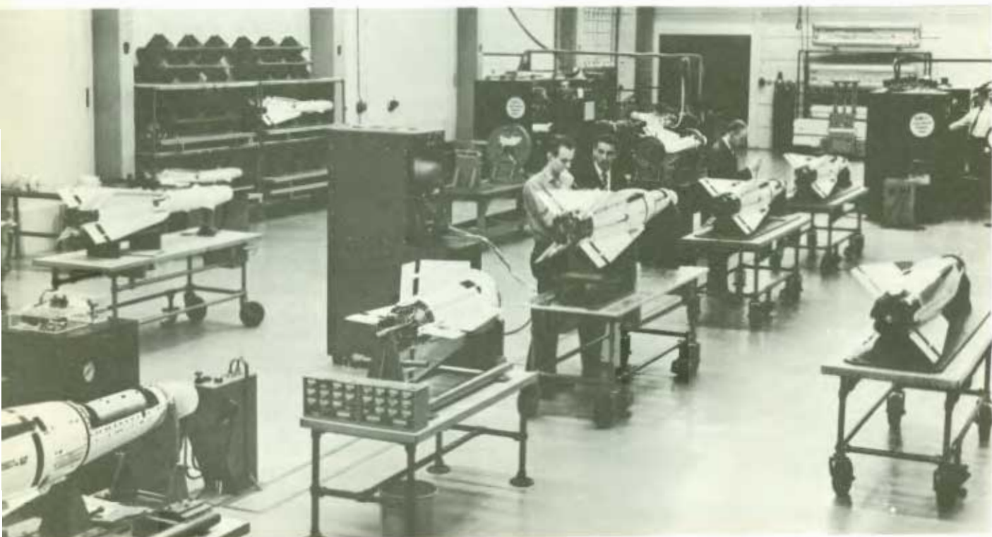
Montering av Falconrobotar
