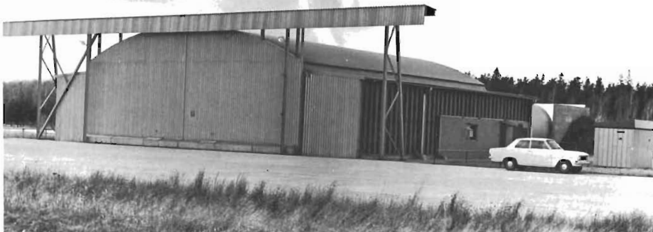
• Inget miljöhotande buller här inte! F6 välfrekventerade ljuddämpningsanläggning "sväljer" allt ljud från A 32:ans motorer.
