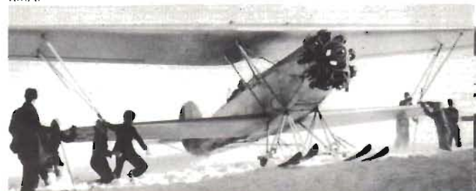
Ovan: 1930 erhöles sju S 6, Fokker CV-E. Här vid F4:s sjöflygstation vid Bynäset, Storsjön. — Nedan: S 6 var ett spanings-lpl, men försågs med kul-sprutor. Dessutom kunde en bombast på max 100 kg medfölja. Fart 210 km/t.
