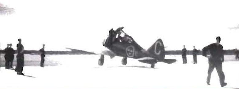
Vid slutet av VK2 överfördes det då omoderna jaktflygplanet J 9/Republic EP-1 till flygspaningen. Omdöptes till S 9C och utrustades med en fast sidriktad kamera, som monterades i den gamla "mekanikerskrubben" bakom föraren. Trots att planet var omodernt betydde detta att en ny spaningsfilosofi hade skapats — ett relativt snabbt, litet flygplan för spaning från låg höjd gjorde entré.
