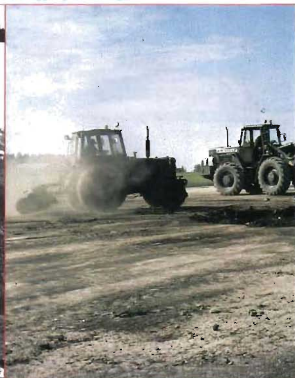
Med rätt material och återfyllning snabbt och ny beläggning kan anläggas
