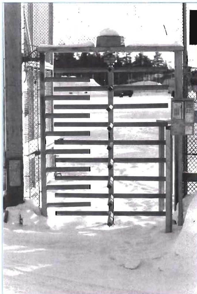
Rotationsgrind för personentré. I h om grinden finns en kortläsare för FV:s nya ID-kort samt en porttelefon för sådana som inte har giltigt kort för säkerhetszonen.
