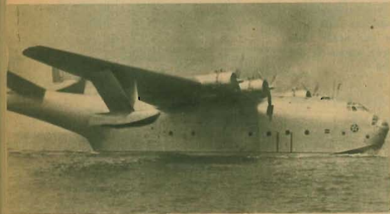
MARTIN »MARS» , jätteflygbåten på 70 ton, har nyligen tilldelats US Navy. Planet, som kan medföra över 15 tons last, har under proven flugit non-stop 7 360 km på 32 tim 17 min. I en dykning med motor från c:a 4 000 m höjd utsattes varje vinge för en påkänning som motsvarade 210 ton. Data återfinnas under klippbild i FLYG nr 21/1943.
