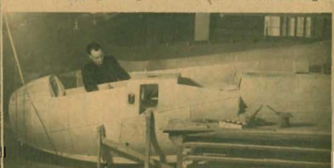
Detaljmonteringen sker på »vinden». Här nedan några Kranich-kroppar i rad med förman Johan Thölin vid den främsta. — Den bästa fotografirum som verkställare Göte Andersson kan tänka sig är ett kroppspant till Kranich. — Längst t v: efter detaljmonteringen bäres Kranich-vingen på en fälld brygga genom golvet-taket ned till slutmonteringen.
