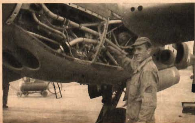
T v översyn på en av P-38:s Allison-motorer.
