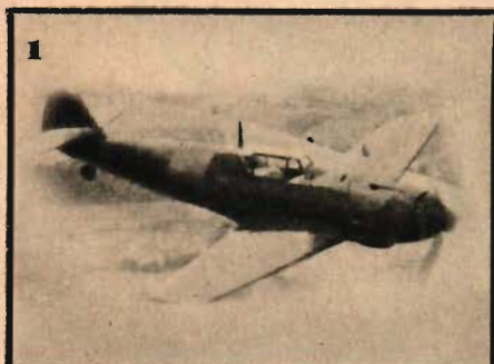
1 ME 109 E: Lågvingat. Tvärvskurna vingspetsar. Låg försänkt huv. Liten stjärt med lågt avrundat stjärtsdplan och högt ansatt stablissator. Jfr. Mustang, Bell Aira Cobra, Spitfire, Lagg 3.
