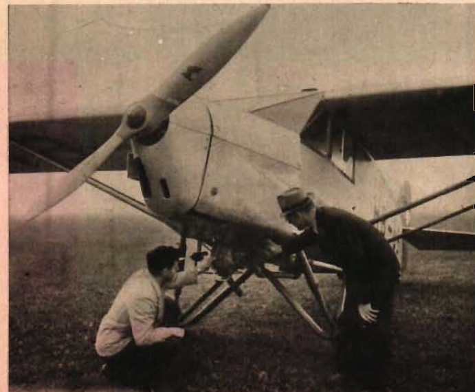
T. v. det första gengasplanet, den schweiziska AC-4. Motorn är ej på minsta sätt ändrad men försedd med kompressorsystem. Aggregatet är ett vanligt bilaggregat.
