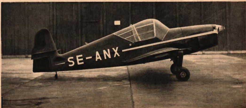
På nedanstående bild rakt från sidan kan man urskilja det delade sidrodret.
