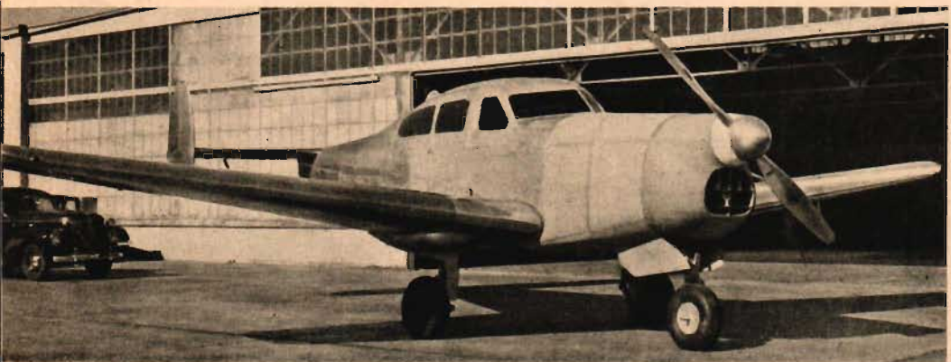
Typ nr 3: Vega »Starliner» (ovan), amerikanskt tvåmotorigt metallplan med 520 hk, plats för 5—6 pers. Maxhast 338 km/t.
