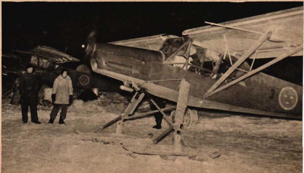
De två »fjällstorkarna» står här nedan startklara i gryningen, väl varmkörda av de morgonpigga mekanikerna. Observera träcklossarna under skidorna för att hindra att dessa fryser fast vid snön.
