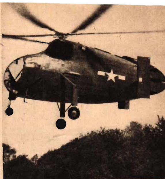
Helikoptern Kellett XR-8 i luften. Motorn är på 245 hk och rotorsystemet nytt och epokgörande.
