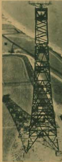
Exempel på ekoradioantennor placerade på höga mastar för att kunna upptäcka lågt flygande flygplan.
