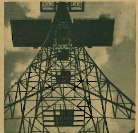
Exempel på ekoradioantennor placerade på höga mastar för att kunna upptäcka lågt flygande flygplan.
