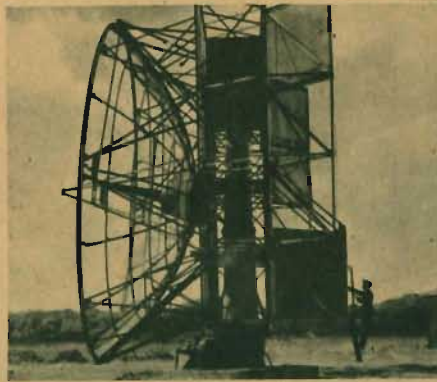
Två exempel på fasta ekoradioantennor för spaning mot flygplan.
