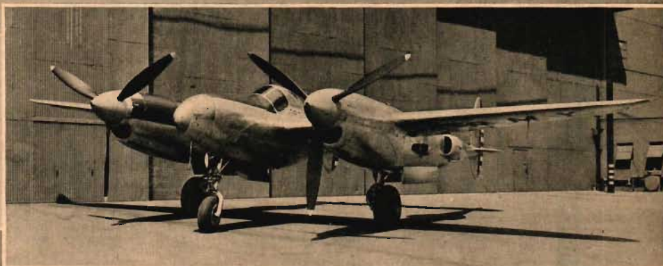
»Pathfinder» Lightning kallas denna specialversion som mot krigsslutet ersatte »Droopsnoot» på motsäende sida. Den huvudsakliga nyheten var att bombfällaren förutom sin fällningsutrustning disponerar en ekoradioanläggning.
