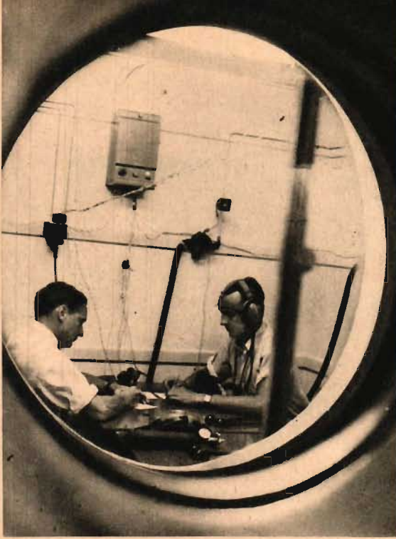
Fig 10 (t v): Prov i u-kammaren vid GCI, låg höjd. — Fig 11 (t h): Prov i u-kammaren, stor höjd. Försöksledaren använder den amerikanska syrgasutrustning som finnes i J 26 Mustang. »Provflygaren» använder AGA syrgasutrustning som finnes i övriga svenska militära flygplan.
