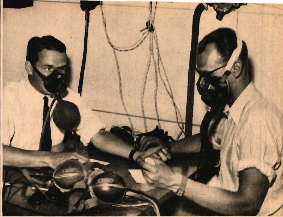
Fig 10 (t v): Prov i u-kammaren vid GCI, låg höjd. — Fig 11 (t h): Prov i u-kammaren, stor höjd. Försöksledaren använder den amerikanska syrgasutrustning som finnes i J 26 Mustang. »Provflygaren» använder AGA syrgasutrustning som finnes i övriga svenska militära flygplan.
