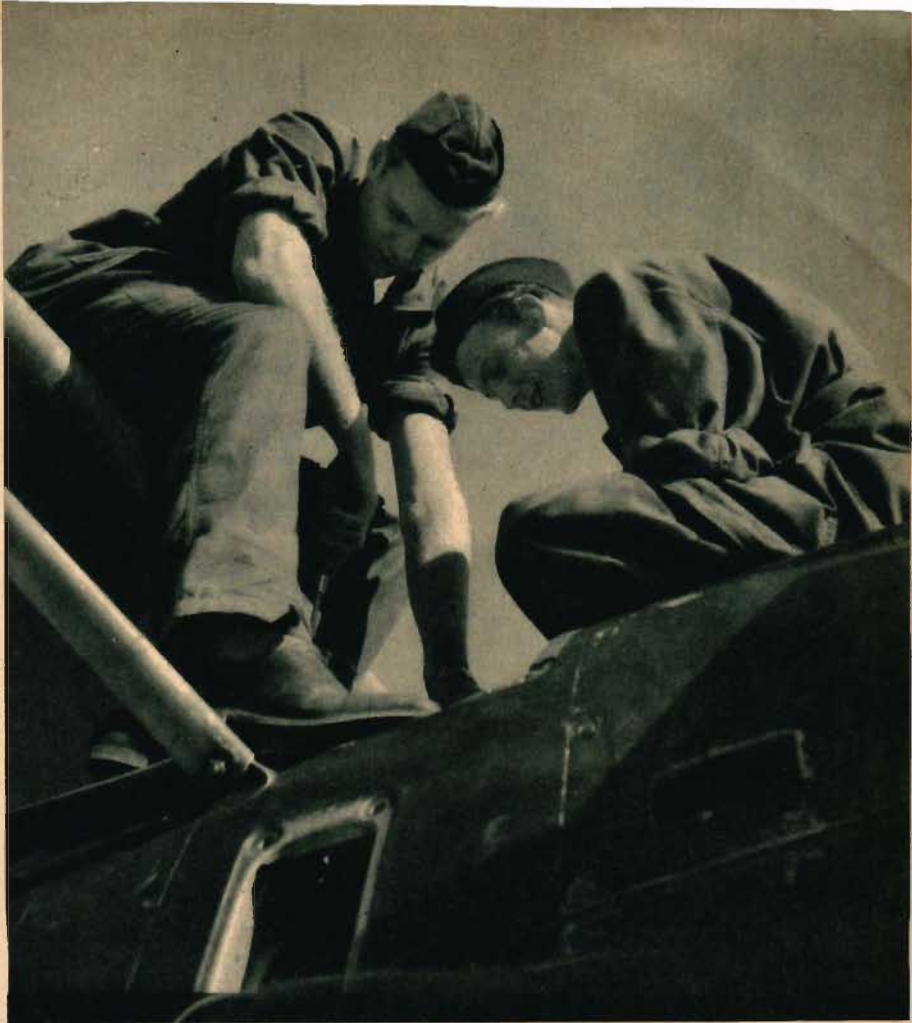
Översyner av olika slag ingår i den dagliga rutinen. BENGT KARLSSON och UNO THÅNG har fått i uppdrag att skruva loss några motorplåtar på en S 12. — Nedan t. v.: KJELL SVEDBERG och en av flottilljens vakthundar, schäferen »BUSS», tar »plats» under en exercisövning i det fria. — Nedan t. h.: För större översyner dras flygplanen upp på landbacken och här håller SVEN-OLOV SCHYBERG på att trimma en S 17-motor.
