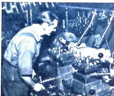
Skruvning av växlar är ett precisionsarbete där hundredelar av millimeter många gånger är grovare mått. — T. v. håller POLKE ANDERSSON på att bearbeta råmutterstillet till en 6-cylindrig dieselmotors växel.
